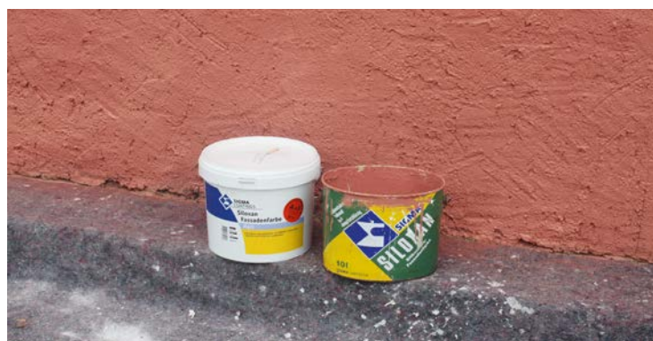
Der neue Farbton der Fassade wurde anhand des dreißig Jahre alten Gebindes (rechts im Bild) mit einer komplett neuen Farbtonrezeptur nachgestellt.
