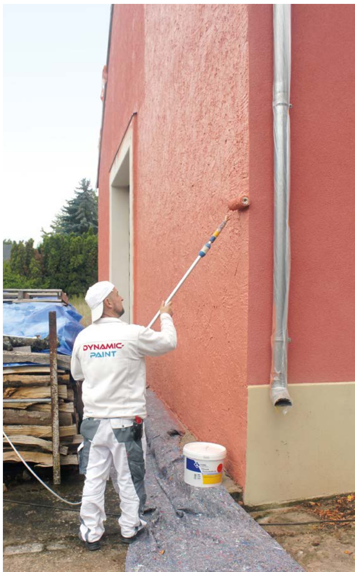
Vor dreißig Jahren wurden die Gebäude auf dem Hof von Jean-Pierre Barthel erstmals mit Sigma Siloxan gestrichen – und nun mit der heutigen Version.
