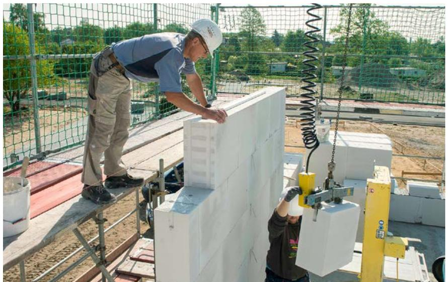
Die Außenwände der Einfamilienhäuser in den „Schildower Gärten“ wurden aus 365 mm dicken SHI-zertifizierten H+H Porenbetonsteinen im Dünnbettverfahren erstellt. So entstand ein hochwertiges und homogenes Mauerwerk mit monolithischem Aufbau, das sowohl die Anforderungen an KfW-Effizienzhäuser 55 als auch alle Anforderungen an einen wohngesunden Baustoff erfüllt.
