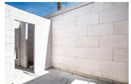
Die Konstruktionsdetails wurden entsprechend DIN 4108 Bbl. 2 ausgeführt. Der angestrebte Wärmeschutz wurde problemlos erreicht – ohne nachträgliche Dämmung der Fassade in den oberen Geschossen und mit einer durchgängig vollmineralischen, monolithischen Außenwandkonstruktion.
