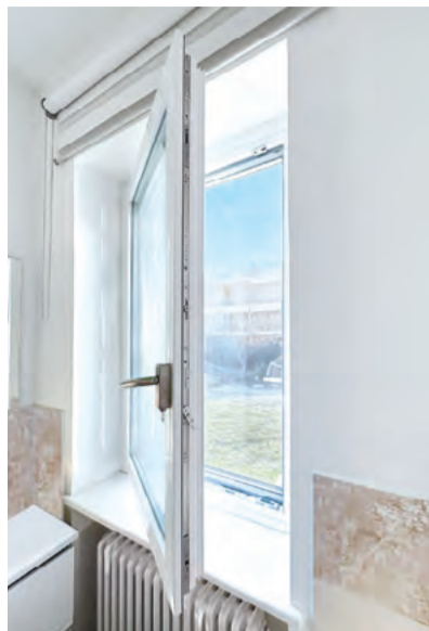
Bild oben: ein Drehkipp-Fenster von AR.MA. mit einer Kreiszwinge als zusätzlicher Mittelverschluss zur Verbesserung des Einbruchschutzes.
