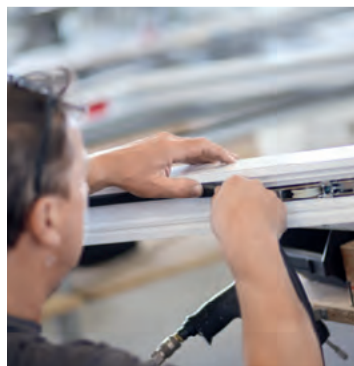
Die Mitarbeitenden von B.FT montieren mit großer Routine Schiebeelemente mit Roto Patio Inowa.
