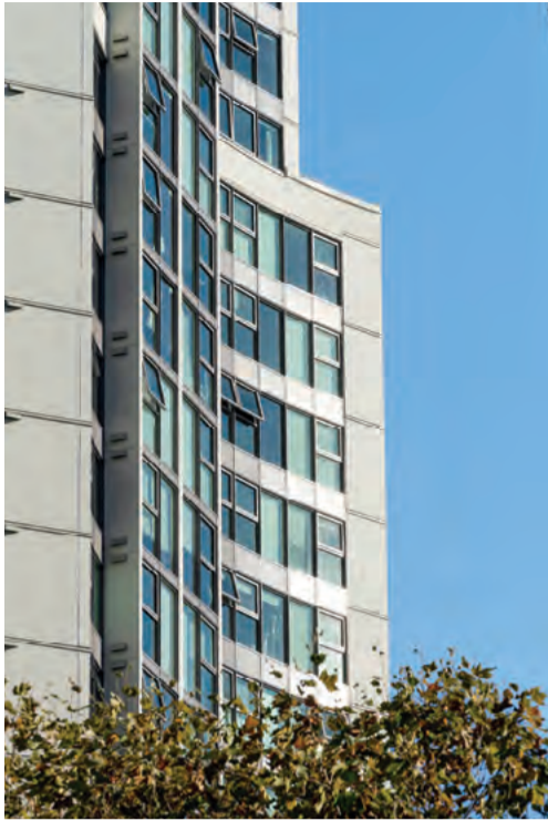
Cascadia und Roto unterstützen ihre Kunden mit optimalen Lösungen wie zum Beispiel diesen hochdichten Fenstern im „Pacific Point II Reha“ in Vancouver, British Columbia, Kanada.
